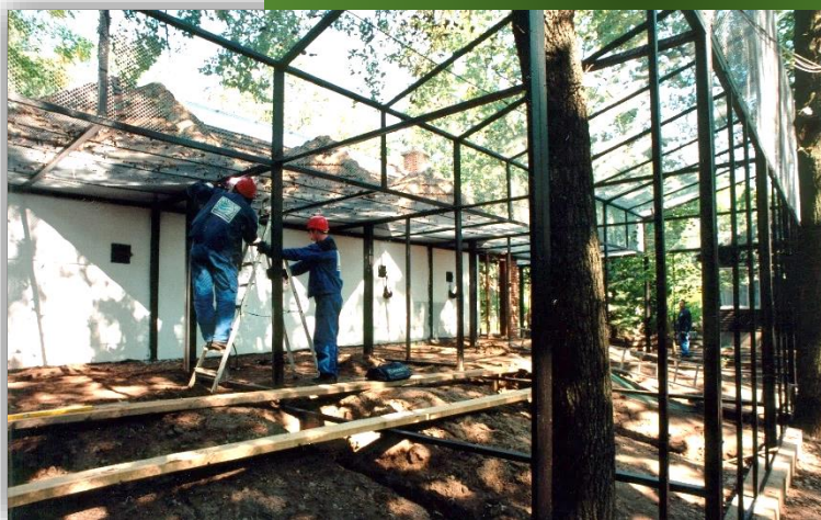
A Dél-Amerikai Esőerdő Ház (külső) építése 2003-ban
