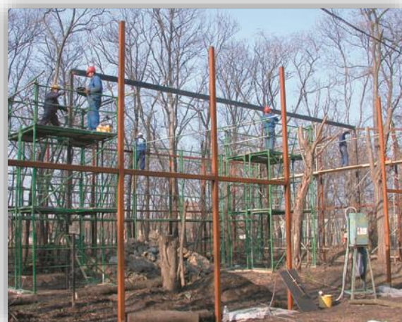
A hópárduc kifutó építése 2002-ben.
