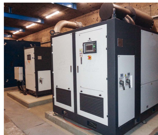
2018 évben és 2019 évben beüzemelt TurboMax 500D és TurboMax 250C légfűvők
