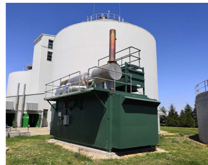
Konténerbe szerelt 500 kW elektromos teljesítményű biogázmotor
